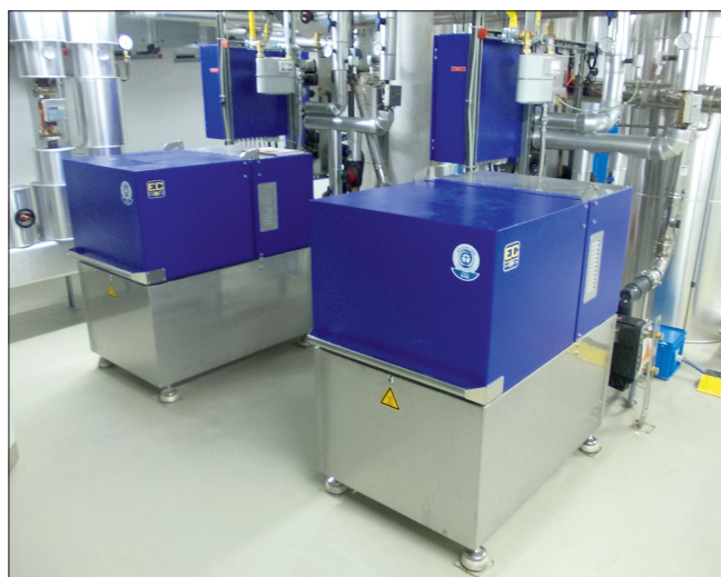
Contractinganlage Wohnanlage Cortendorf
