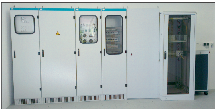
Unterbrechungsfreie Spannungsversorgung sowie Fernwirk- und Schutztechnik (oben) und gasisolierte Leistungsschalteranlage als Doppelsammelschiene mit Querkupplung 1.250 A (links) im Schalt haus Heldburg
