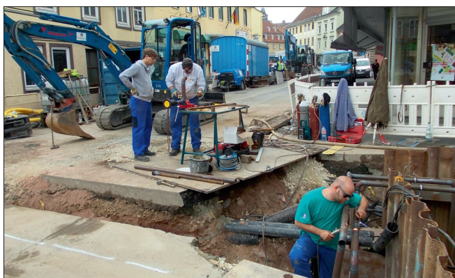
Schachtsanierung in der Bahnhofstraße
