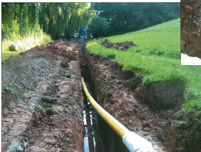
Neuerlegung der Erdgas Hochdruckleitung im Küregrund
