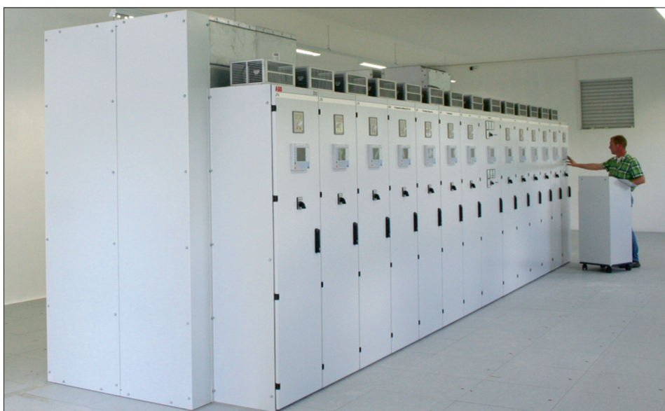
Unterbrechungsfreie Spannungsversorgung sowie Fernwirk- und Schutztechnik (oben) und gasisolierte Leistungsschalteranlage als Doppelsammelschiene mit Querkupplung 1.250 A (links) im Schalt haus Heldburg
