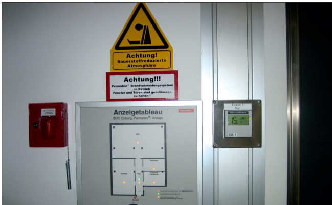
Anlagenteile der Sauerstoffreduzierung
