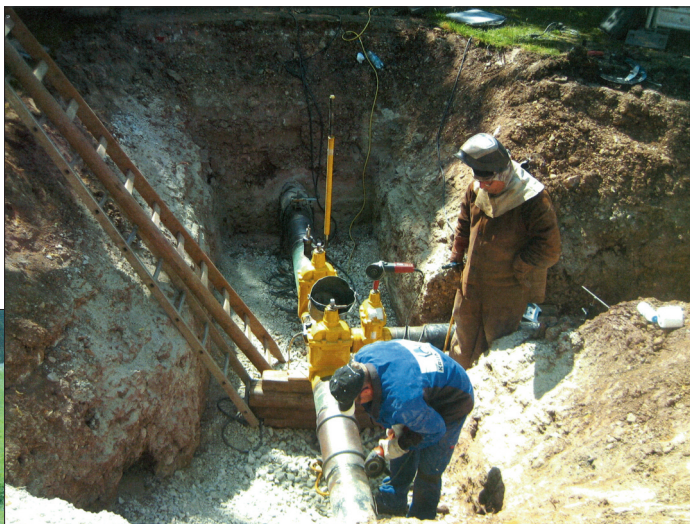
Neuerlegung der Erdgas Hochdruckleitung im Küregrund
